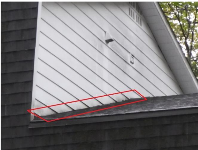
Solin à la jonction d'un mur recouvert de bardage
